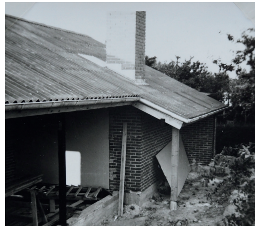
Byggeriet nærmer sig afslutningen. Privatfoto
