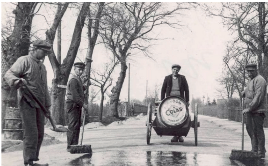
Vejarbejdere i gang med overfladebehandling af vej med Colas-tjære. 1930 Kilde:www.colas.dk
