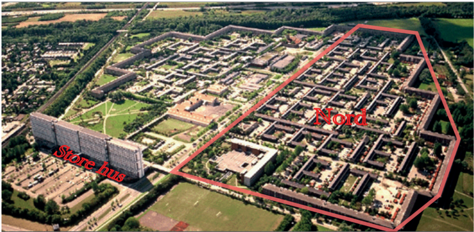
Avedøre Stationsby med angivelse af Nord og Store Hus - Foto: HVA Luftfoto af A.S.
